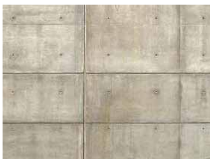
Omålad betong, gjuten mot skivform
