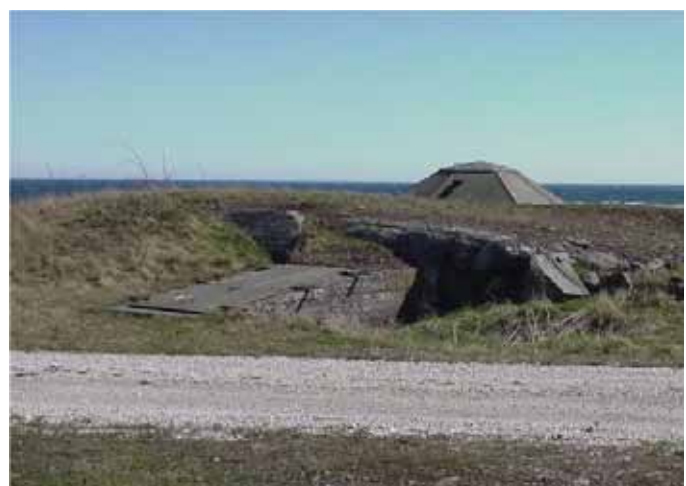
Befintlig byggnad nr 62 straxt nedanför vägen
