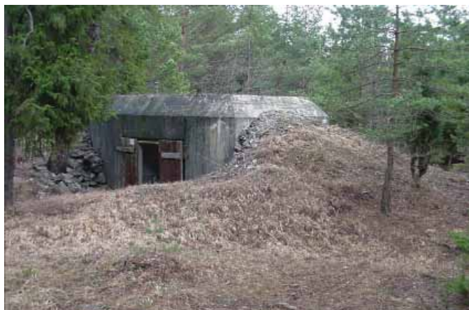
Platsfoto. Bunker i området
