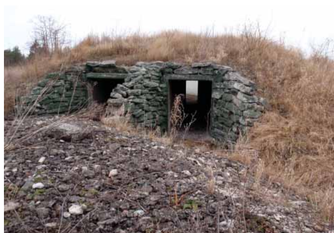
Befintlig ingång till bunker, kamouflagemålad kalksten
