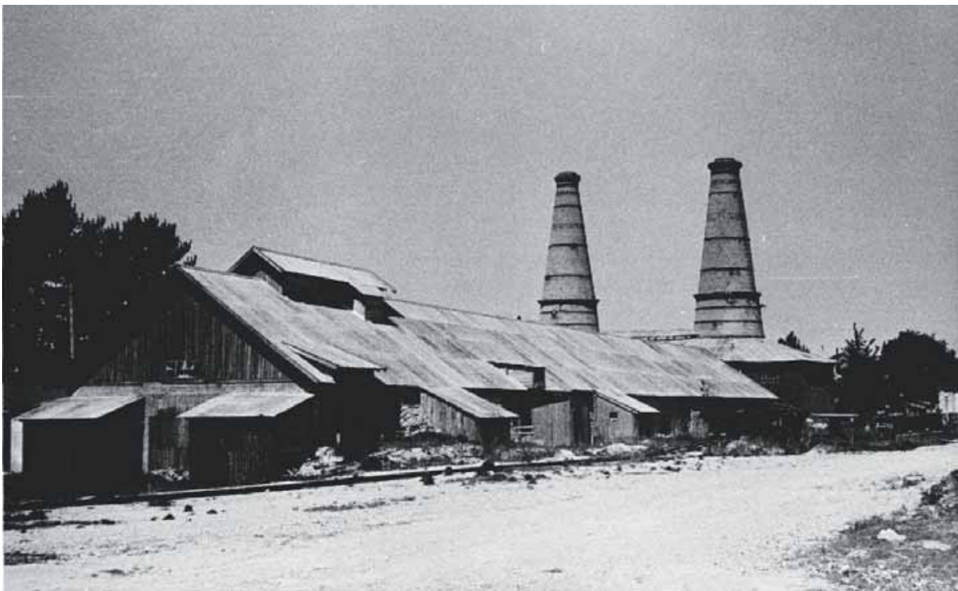
Kalkladan och de kringbyggda ugnarna.
