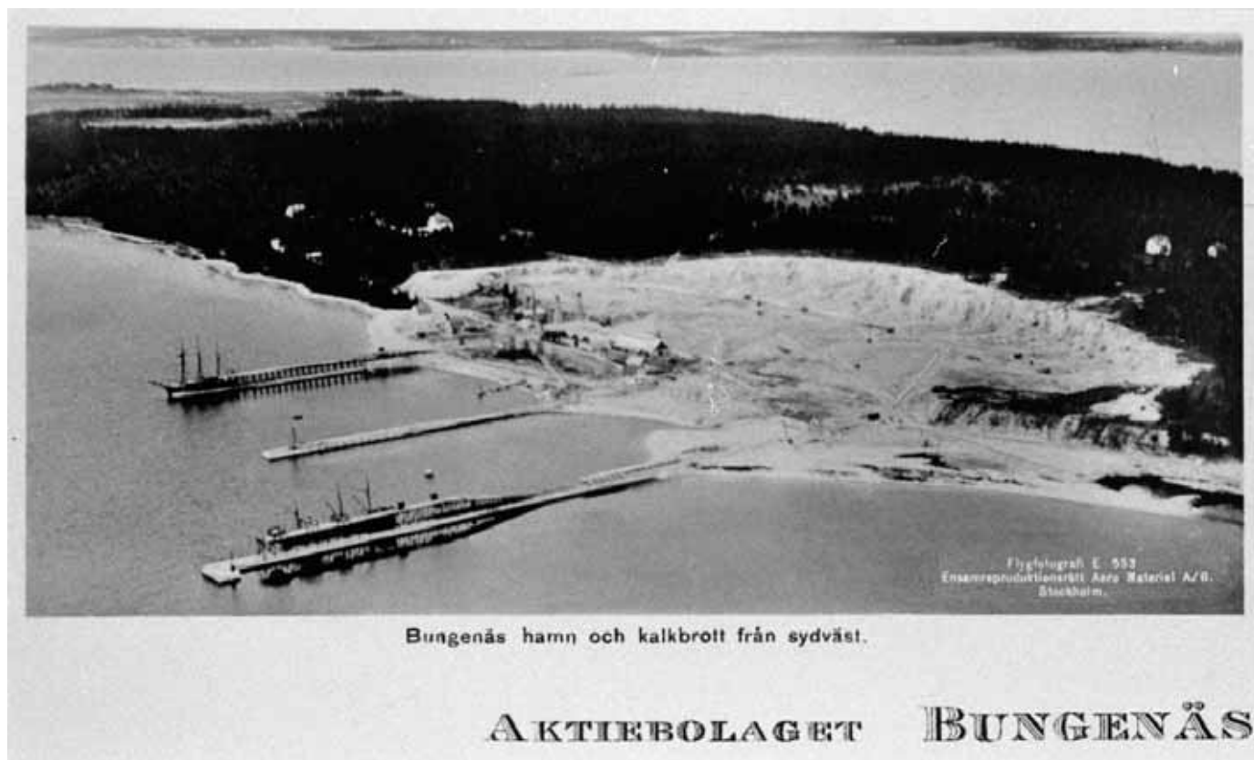
Bungenäs kalkbrott från Sydväst, 1929
