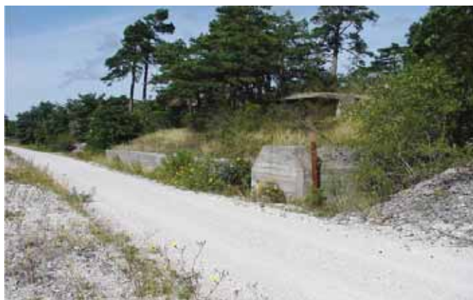
Bunker, byggnad nr 65 och vägspärren nedanför Sahara
