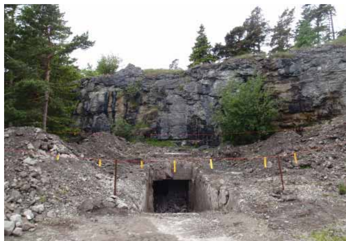
Nedgång till Kustspaningsradarstationen, byggnad nr 101
