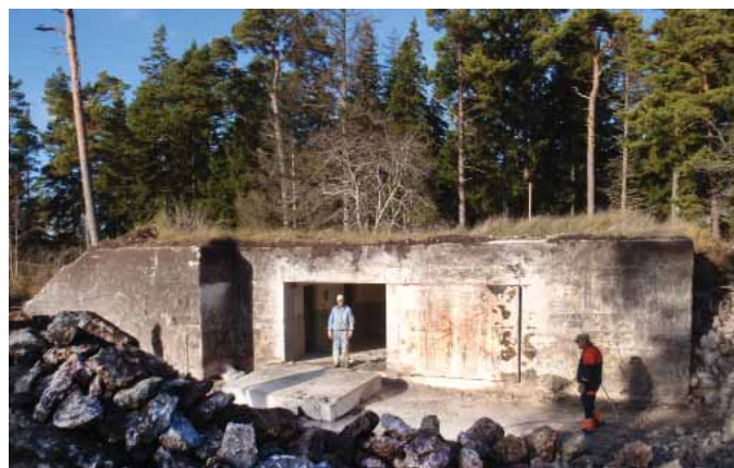
Friläggning och håltagning, byggnad nr 8
