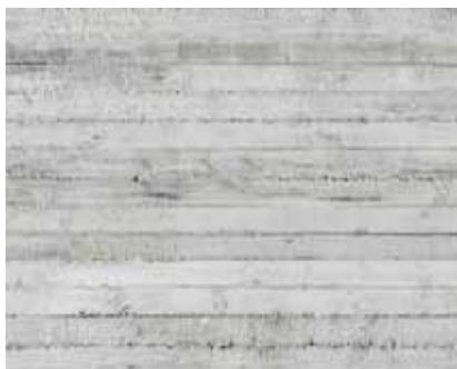
Omålad betong, gjuten mot brädform
