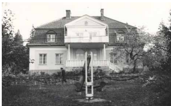
Förvaltarvillan med påbyggd balkong ca 1940-tal
