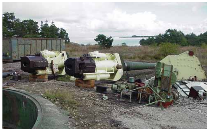
Nedmontering av pjäsvärn (byggnad 104)
