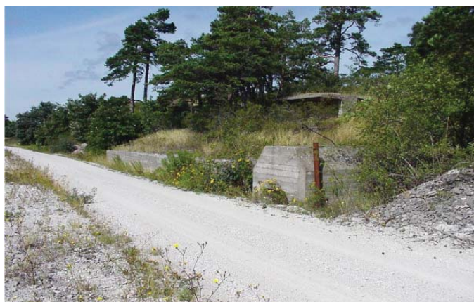
Bunker, byggnad nr 65 och vägspärren nedanför Sahara
