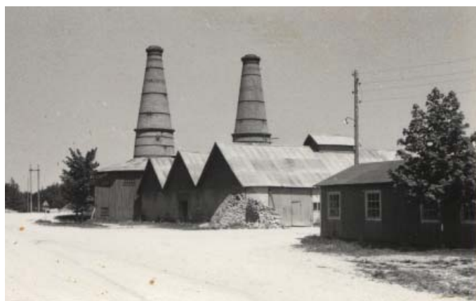
Ugnarna var kringbyggda med verkstäder, maskinhall och magasinbyggnader för lagring av den brända kalken.
