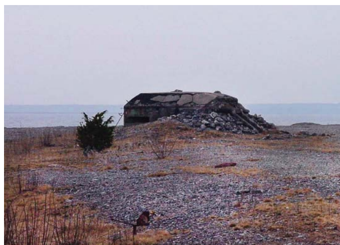
Befintlig byggnad nr 22:34
