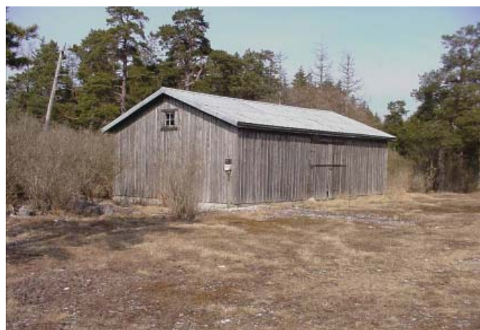
På Savannen riven byggnad nr 88, Fortifikationsverket Naturligt grånad virke som fasadmateriel. Enkel volym, nockhöjd ca 4m
