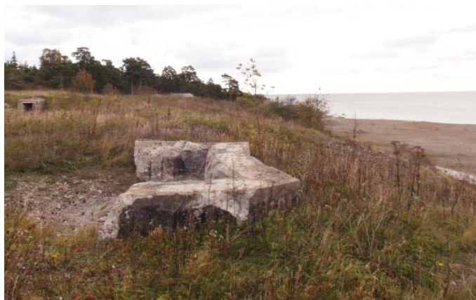
Resterna av pjäsvärn 64 är osynligt från vägen och brottet då det ligger 11 meter över havet. På baksidan mot brottet skapas ett vindskyddat rum bakom den meterhöga betongväggen.
