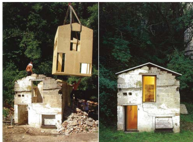
Inspirationsbild. Modern, isolerad trästomme inpassad i ett befintligt skal/ruin av betongsten. Den lätta takkonstruktionen upplevs sväva över det ojämna murkrönet
