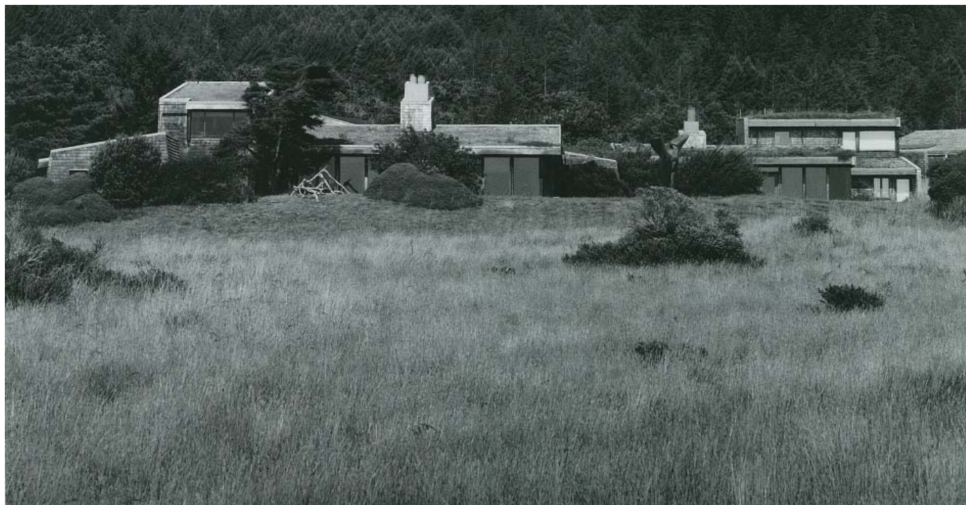
Referensprojekt, byggnader i skogsbrynet. Kirkwood Houses, Paul Hamilton Sea Ranch, USA
