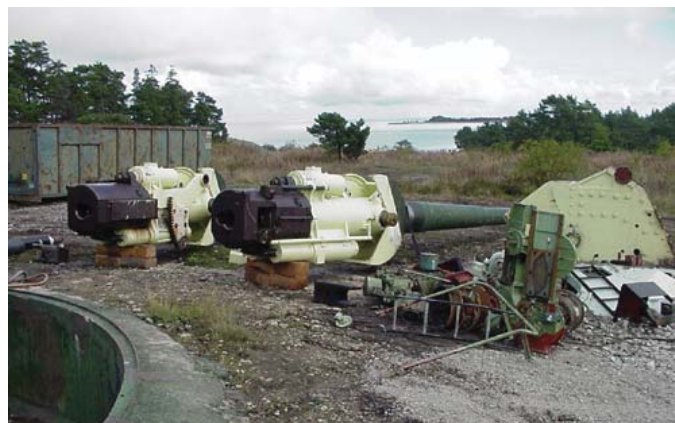
Nedmontering av pjäsvärn (byggnad 104)
