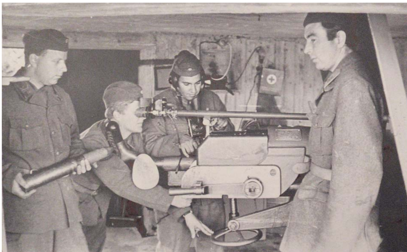
Laddning av 57mm pjäs, Batteri Österklint (ÖK)
