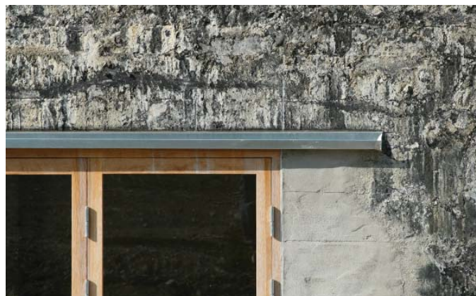
Befintligt möter nytt! Den framgrävda betongfasaden, bestruken med varmasfalt är uppsågad för lokalproducerade glaspartier i gotländsk oljad kärnfuru. Ränna ovan glasparti i zinkplåt.
