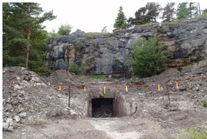
Foto, Skälsö Arkitekter. Friläggning av nedgången till byggnad 101 i Österklintbrottet 2010.
