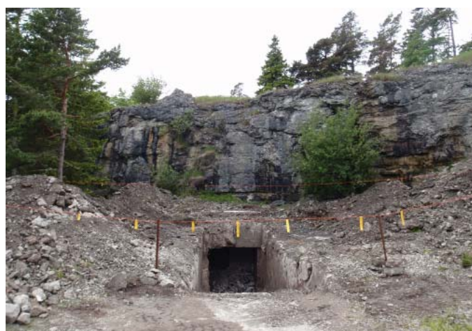
Nedgång till Kustspaningsradarstationen, byggnad nr 101
