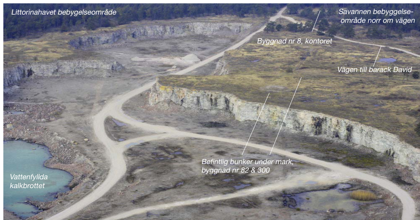
Den öppna hållmarken mellan vägen och brottkanten lämnas obebyggd bortsett från mindre nybyggnader i anslutning till befintliga bunkrar nr 82 & 300. Flygfoto: Claes Martinsson
