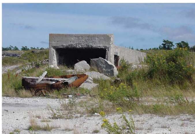
Den 80m långa transporttunneln vid yttre piren, fabriksområdet
