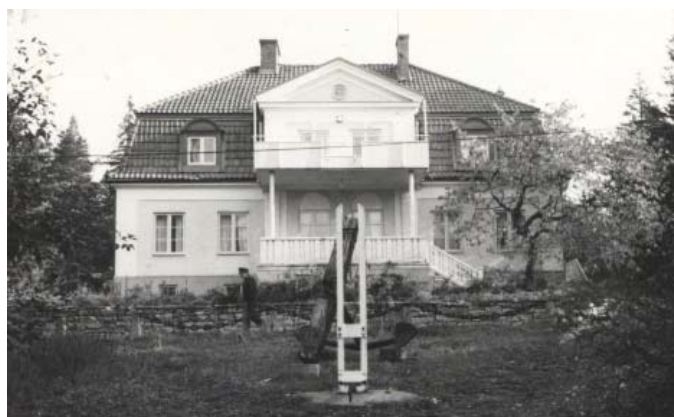
Förvaltarvillan med påbyggd balkong ca 1940-tal
