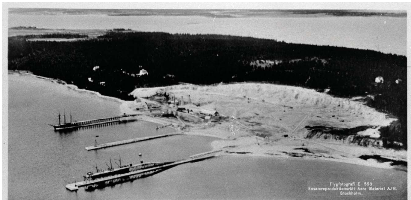
Bungenäs hamn och kalkbrott från sydväst.
