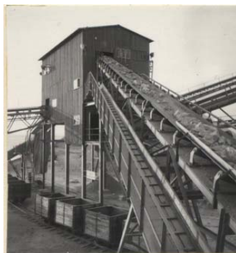
Det numera rivna krosshuset beläget bakom kalkladan, uppfört 1922. Stålstomme klädd med stående grå träpanel
