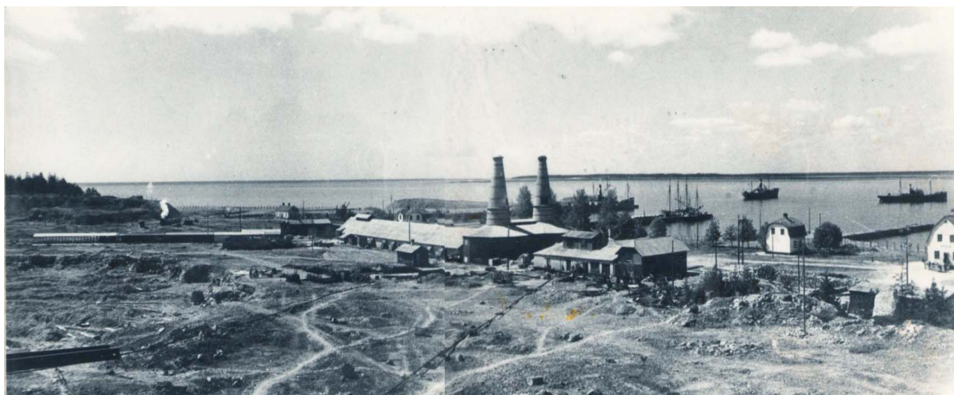
Fabriken och brottet. Bakom ladan skymtar det numer rivna kontoret och arbetarlängan vid yttre piren. Det ångdrivna tågen på ingående från Österklintbrottet. Den långa byggnaden i brottet är en torktunnel i vilken kalkstenen torkades direkt i vagnarna. Längst till höger i bild, Kooperativa förbundets handelsbod.
