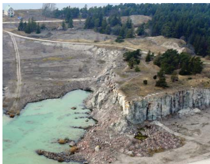
Flygfoto över Västerklintsbrottet. Foto: Claes Martinsson
