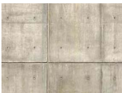
Omålad betong, gjuten mot skivform
