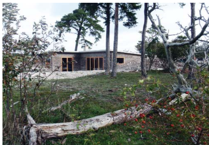
Nybyggnation under uppförande våren 2011.
