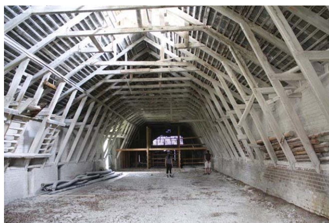
Ladans stora öppna interiör skall bevaras
