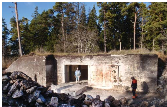
Friläggning och håltagning, byggnad nr 8
