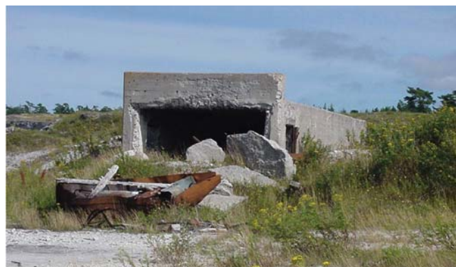
Änden på den 80m långa transporttunneln. I borte änden, i anslutning till vägen, ligger det högre krossverket.
