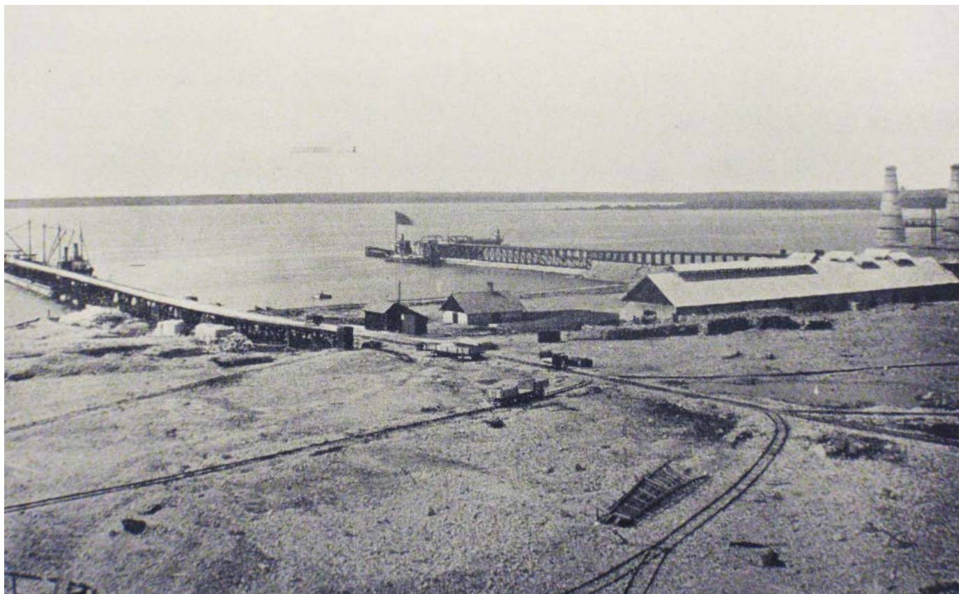
Hamnen och fabriken från sydost. Ugnarna är kringbyggda med stora utrymmen för matning, eldning, tömning mm. Kalkladan har ännu sin långa ljuslanternin och de tre stora magasinerna i vinkel på västra sidan. (se ritning sid 15)
