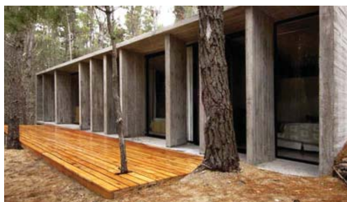
Inspirationsbild, låg betongbyggnad med indragna fönsterpartier reducerar solreflexer mot havet och stranden. Befintliga tallar sparas, även mycket nära byggnaden.
