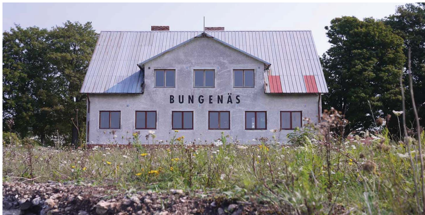
Den svårt vandaliserade och sönderskjutna matsalen, där försvarsmakten övade "Strid i tätort", fick åter fönster och dörrar 2010-11. Byggnaden blir centrum i fabriksområdet med restaurang och hotel. Gräsplan i väster med solnedgången över Sandviken.
