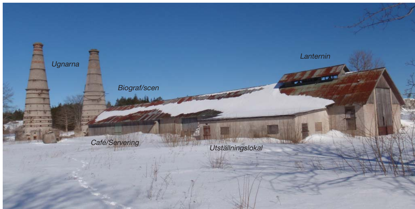
Kalkladan och ugnarna, uppförda ca 1910 i silikattegel Ladan hade tidigare spåntak vilket var det enda material som stod emot flygande stenskärvor från brottet.
