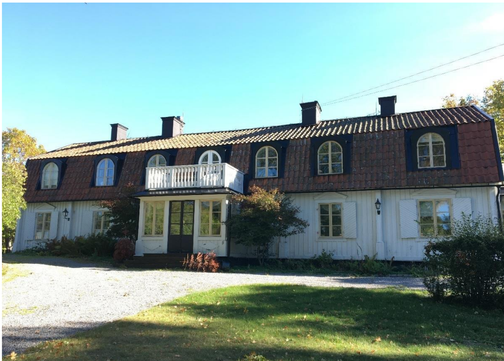
Figur 15. Västra Älvsala Gård, huvudbyggnadens entréfasad. Synligt är mansardtaket med rött lertegel, fönsterkupor, fönstersättning och den vitmålade locklistpanelen.
