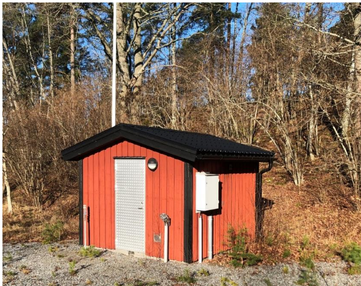
Figur 19. Bild som visar ett exempel på hur pumpstationer kan utformas i Värmdö kommun.
